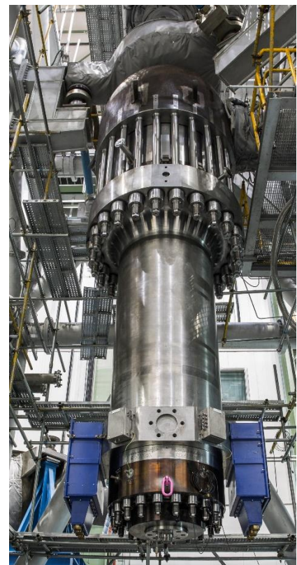
Bild 1: Hauptkühlmittelpumpe, Antriebsleistung 10200 PS [KSB SE & Co. KGaA].
